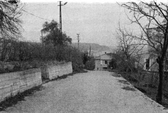
Kemaliye Mahallesi - Beton Yol Çalışması
