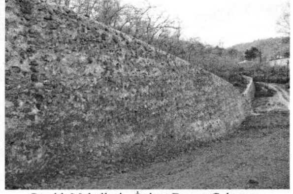
Çamlık Mahallesi – İstinat Duvarı Çalışması
