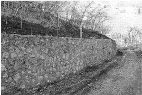
Fevziye Mahallesi – İstinat Duvarı Çalışması
