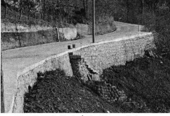
Kirazlık Mahallesi – İstinat Duvarı Çalışması
