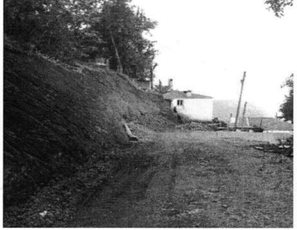
Açıkalın Mahallesi – Yol Genişleme Çalışması
