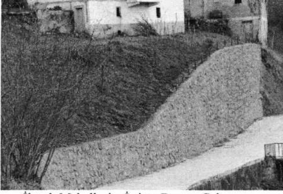
İlyaslı Mahallesi – İstinat Duvarı Çalışması
