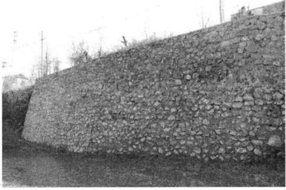
Düzlük Mahallesi – İstinat Duvarı Çalışması
