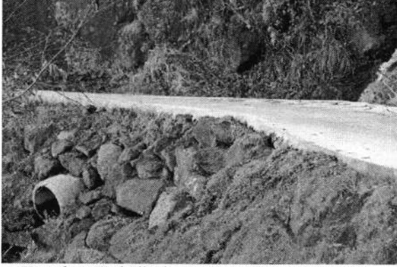
Kıranköy Mahallesi – Yağmur Suyu Çalışması
