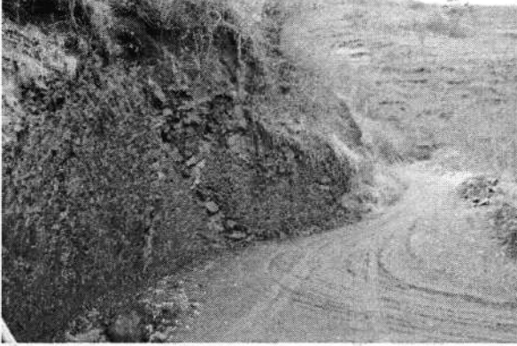
Güneyköy Mahallesi – Yol Genişletme Çalışması
