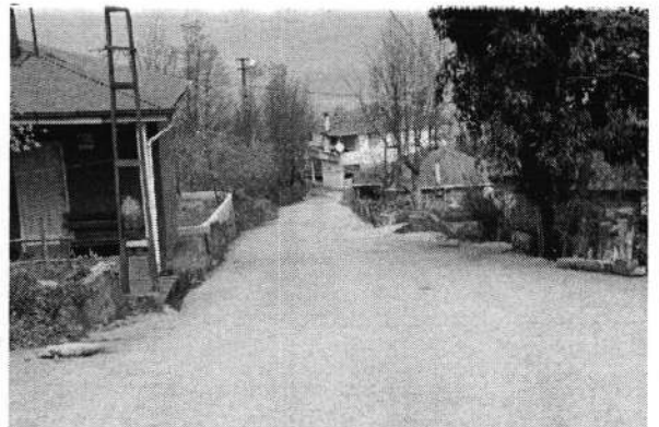
Körez Mahallesi - Beton Yol Çalışması
