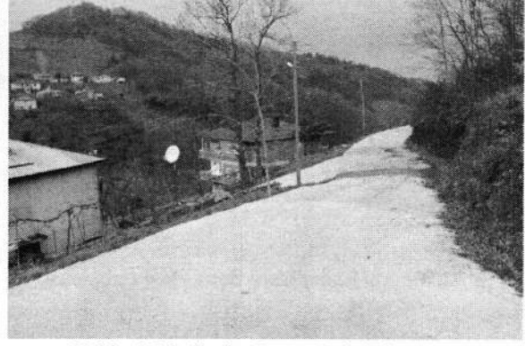
Yıldız Mahallesi - Beton Yol Çalışması
