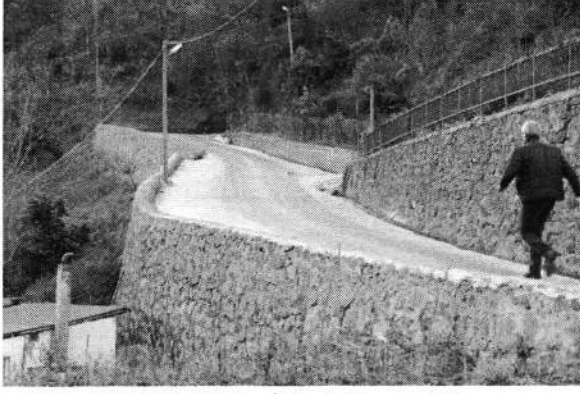
Bahadırılı Mahallesi – İstinat Duvarı Çalışması
