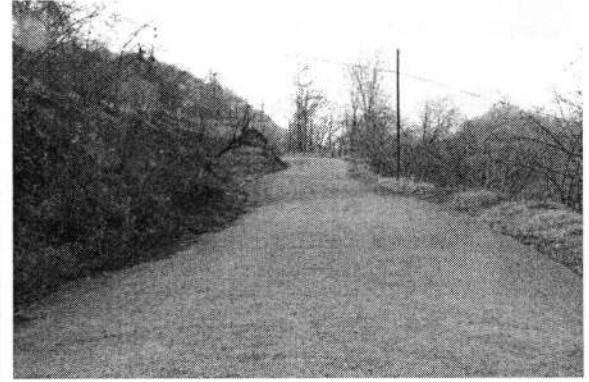
Soğuksu Mahallesi - Beton Yol Çalışması
