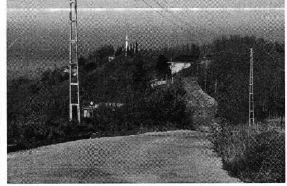
Yalıköy Mahallesi - Beton Yol Çalışması
