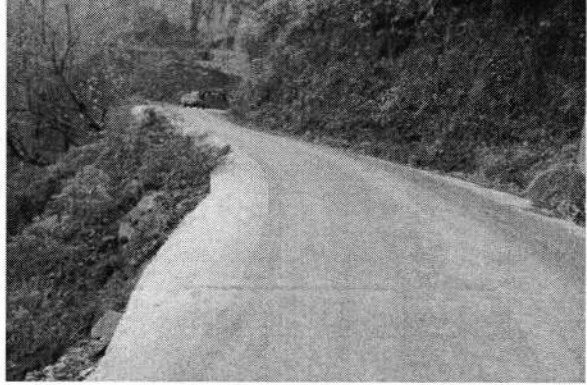
Bahadırli Mahallesi - Beton Yol Çalışması
