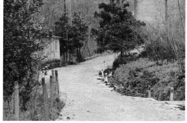
Güneysu Mahallesi - Beton Yol Çalışması
