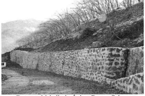
Esetepe Mahallesi – İstinat Duvarı Çalışması
