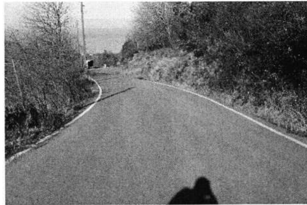
Yalıköy Mahallesi - Asfalt Yol Çalışması
