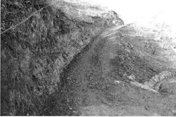
Köprücek Mahallesi – Yeni Yol Açma Çalışması
