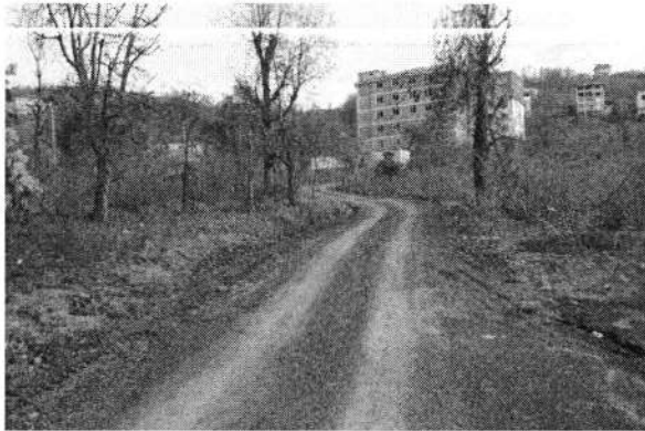
Kirazlık Mahallesi – Yeni Yol Açma Çalışması
