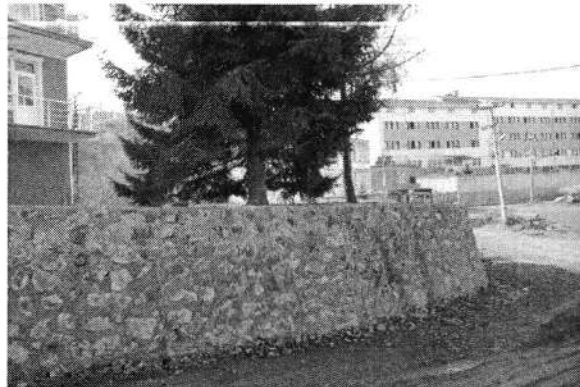
Hacıköy Mahallesi – İstinat Duvarı Çalışması
