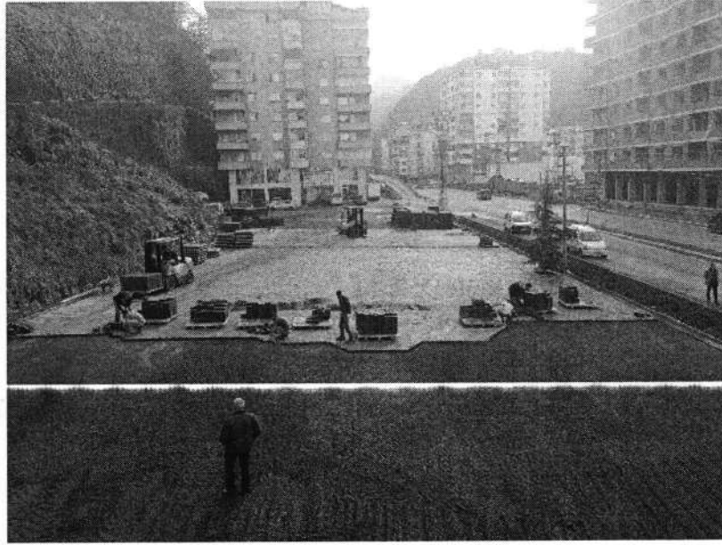
Kemaliye Mahallesi – Parke Taşı Çalışması
