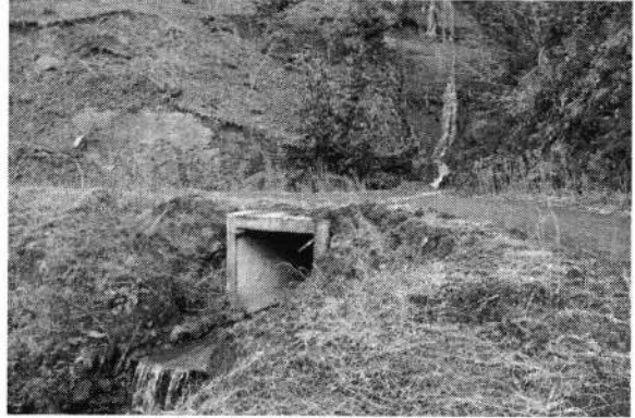
Deregözü Mahallesi – Yağmur Suyu Çalışması
