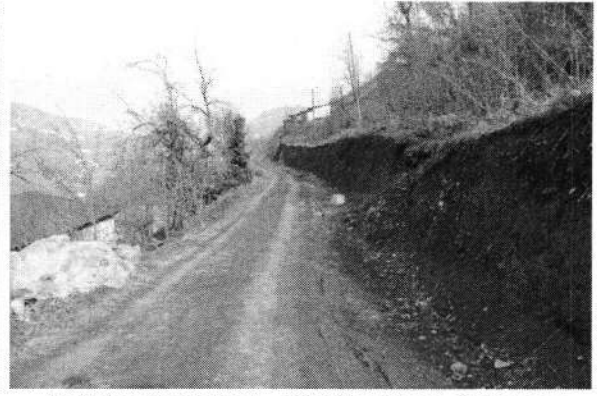
Soğuksu Mahallesi – Yol Genişleme Çalışması
