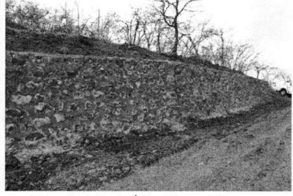
Körez Mahallesi – İstinat Duvarı Çalışması
