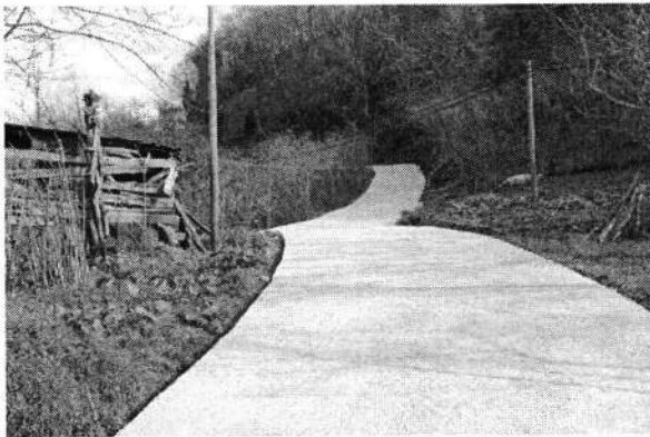
Esentepe Mahallesi - Beton Yol Çalışması
