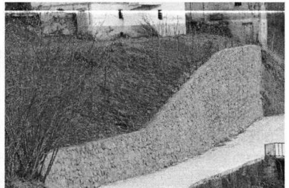
İlyaslı Mahallesi – İstinat Duvarı Çalışması
