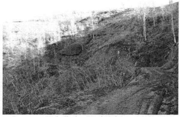
Deregözü Mahallesi – Yeni Yol Açma Çalışması
