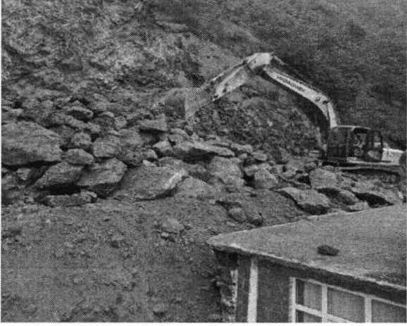
Yaylacık Mahallesi – Yeni Yol Açma Çalışması
