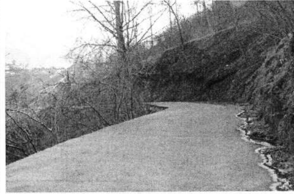
Fethiye Mahallesi - Beton Yol Çalışması
