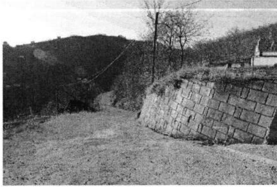
Tarlacık Mahallesi - Beton Yol Çalışması
