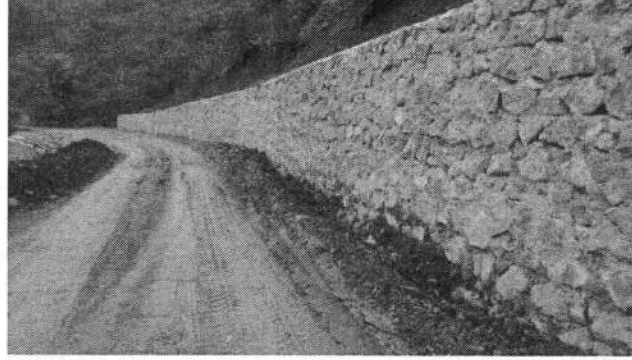
Ballı Mahallesi – İstinat Duvarı Çalışması
