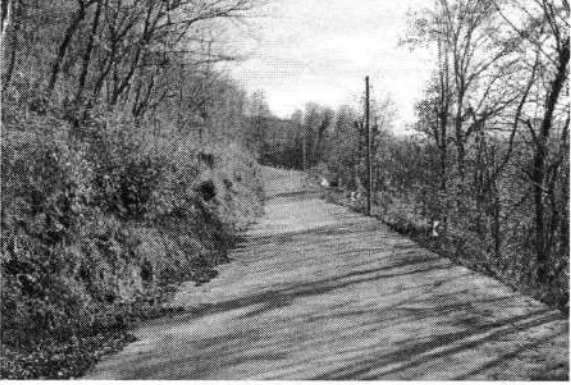
Aydoğdu Mahallesi - Beton Yol Çalışması
