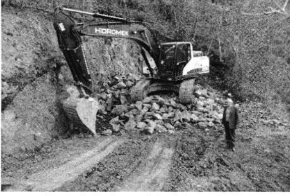
Bozalan Mahallesi – Yol Genişletme Çalışması
