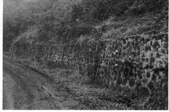
Mısırlı Mahallesi – İstinat Duvarı Çalışması
