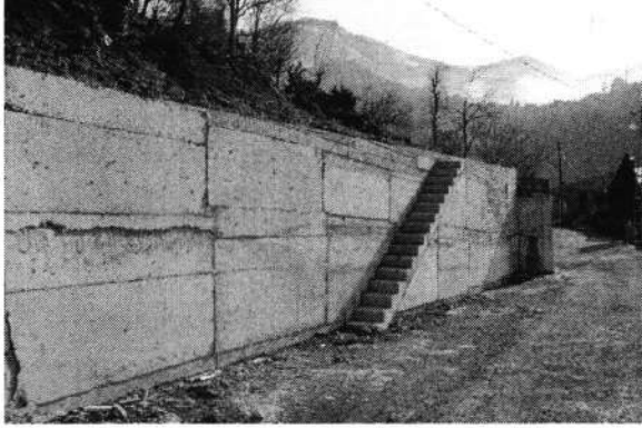
Mahmutlu Mahallesi – İstinat Duvarı Çalışması
