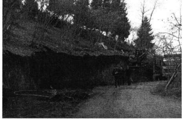
Mahmutlu Mahallesi – Yol Genişletme Çalışması
