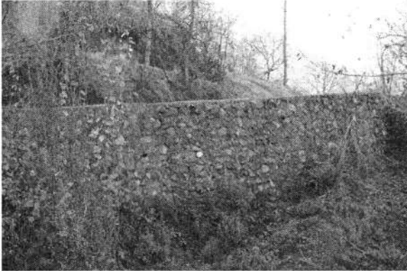
Soğuksu Mahallesi – İstinat Duvarı Çalışması
