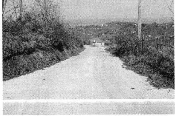
Düzlük Mahallesi - Beton Yol Çalışması
