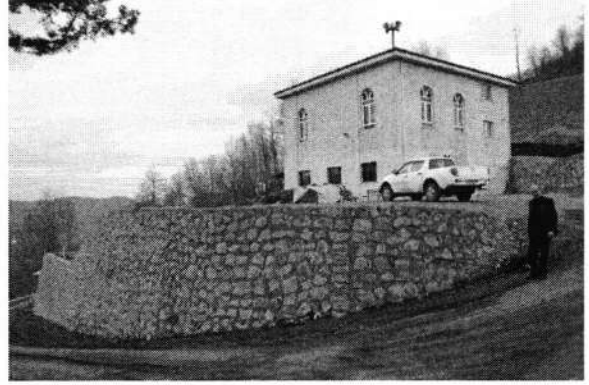
Rıdvanlı Mahallesi – İstinat Duvarı Çalışması
