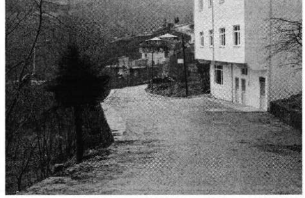
Sekmenli Mahallesi - Beton Yol Çalışması
