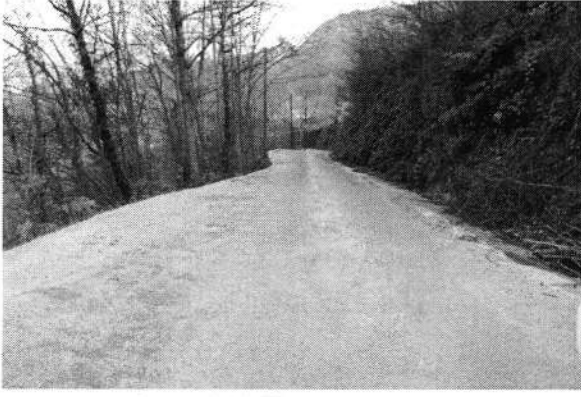
Fevziye Mahallesi - Beton Yol Çalışması
