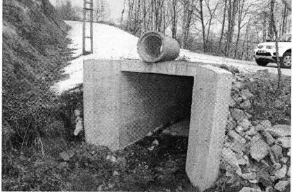
Körez Mahallesi – Yağmur Suyu Çalışması
