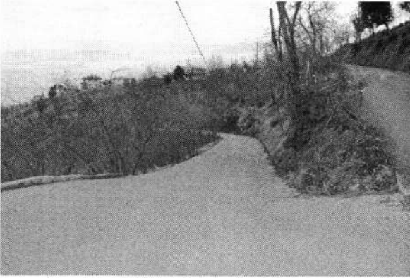
İshaklı Mahallesi - Beton Yol Çalışması
