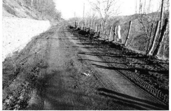
Karatepe Mahallesi – Yol Genişletme Çalışması
