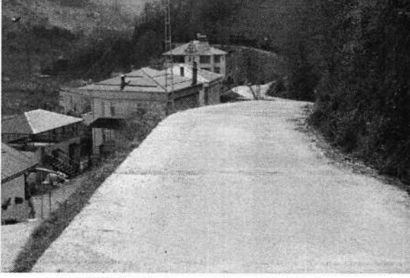
Hacıköy Mahallesi - Beton Yol Çalışması
