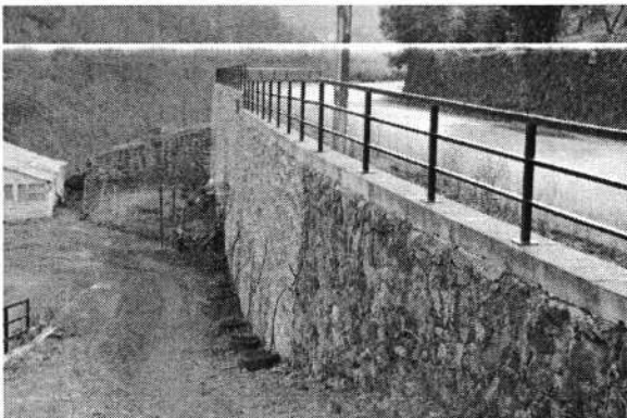
Yıldız Mahallesi – İstinat Duvarı Çalışması
