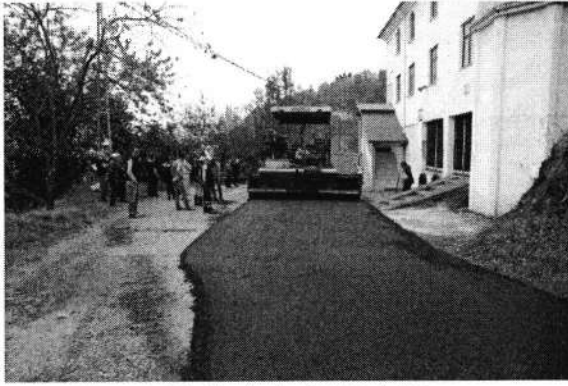
Kıran Mahallesi - Asfalt Yol Çalışması
