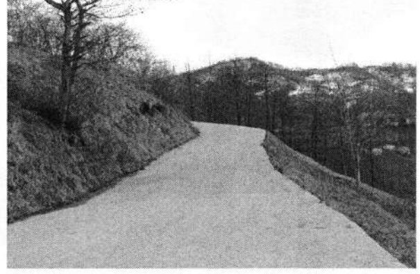
Ortaköy Mahallesi - Beton Yol Çalışması
